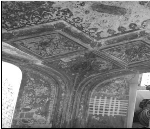
تصویر ۶. رسمی‌بندی‌ها و عرقچین (آرشیو سازمان میراث فرهنگی خراسان رضوی، ۱۳۹۲)
