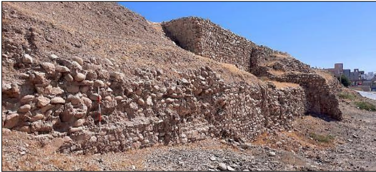
شکل شماره ۱۴. نمایی از ضلع جنوبی بان‌قلعه با مصالح قلوه‌سنگی و ملاط گچی (نگارنده، ۱۴۰۱)
