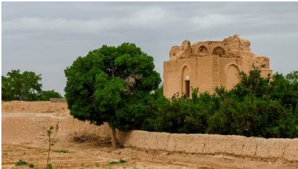
تصویر شماره ۱۶. مسجد جامع مهرآباد (محل صنوبر مهر)، محله کشمیر (کاجمر)
